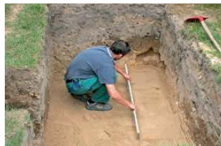
2. leg een vlakke laag wit zand op de bodem
