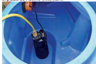
6. plaats pomp in pomphuis
