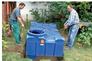
3. plaats de Flatline-(filter)tank
